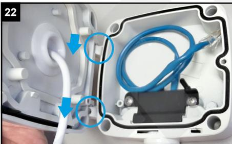
22 Haken Sie die Kamera mit dem Deckel seitlich in die Anschlussbox ein.
